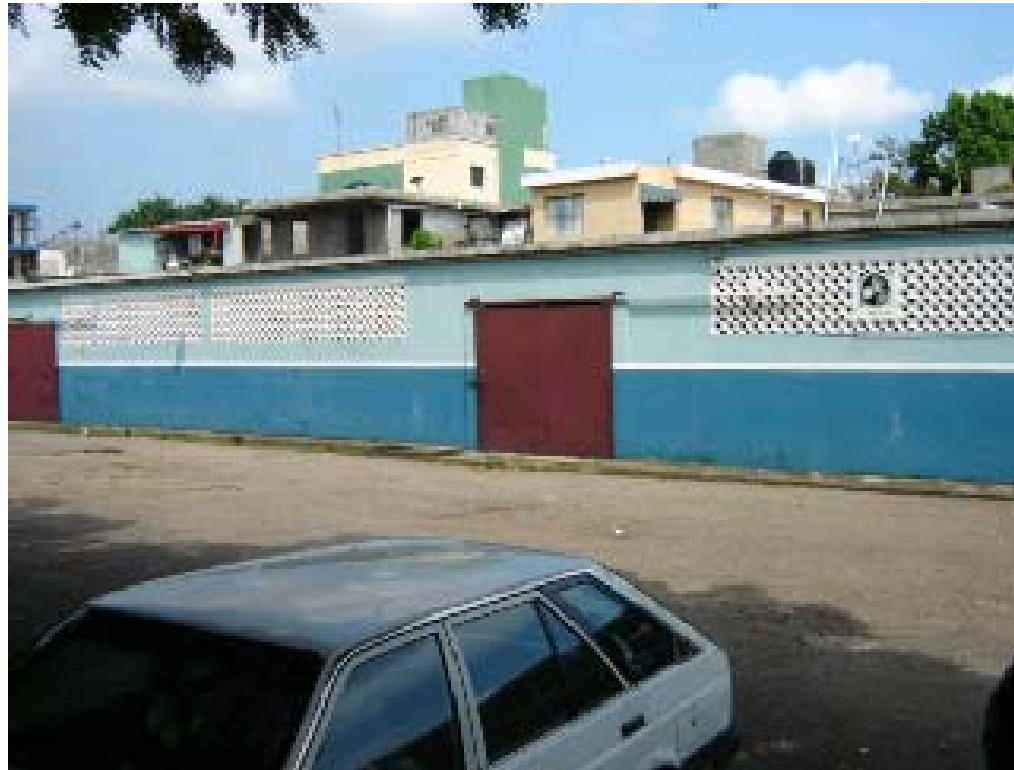
Almacén de DDT y otros productos químicos.
